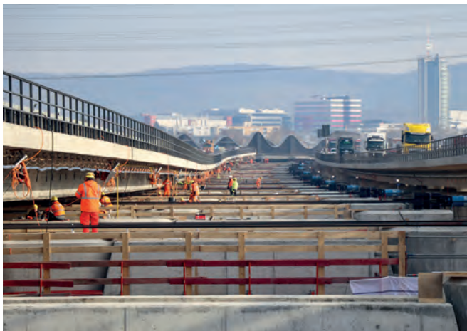
Neckartalübergang - Querverschub
