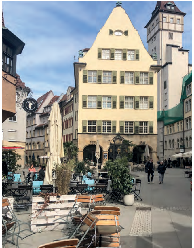
Der Platz nach Fertigstellung
