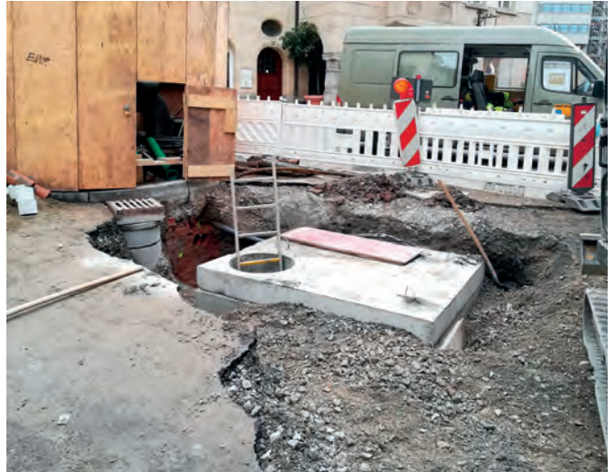
Während der Bauarbeiten
