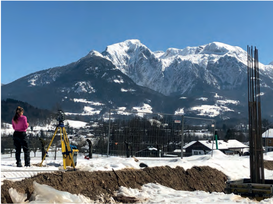
Vermessung des Geländes
