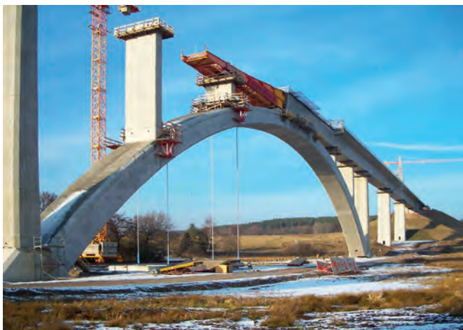
Ilmtalbrücke - Überbau und Bogen Nord
