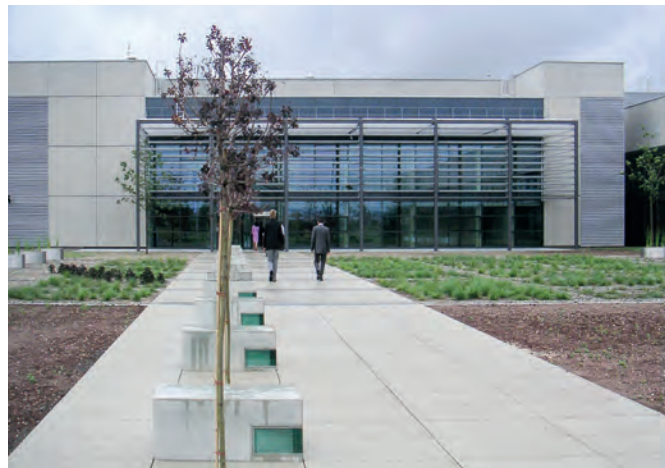
Rechenzentrum RIO - Zentralgebäude
