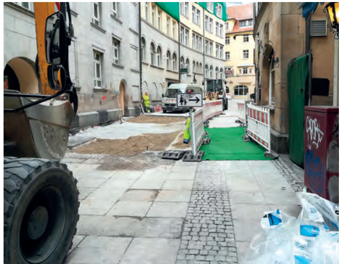
Während der Bauarbeiten
