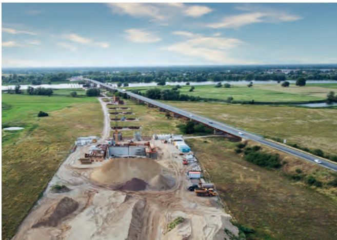
Elbbrücke BAB A14
