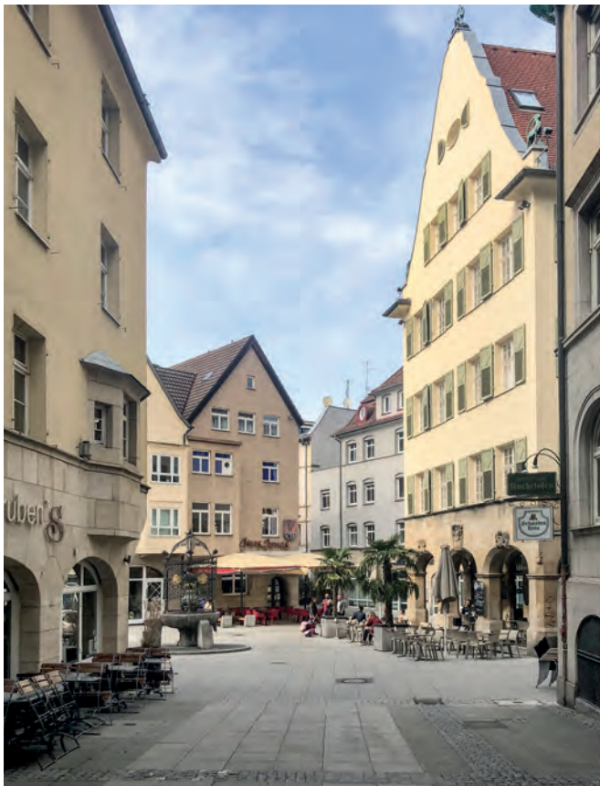
Der Platz nach Fertigstellung
