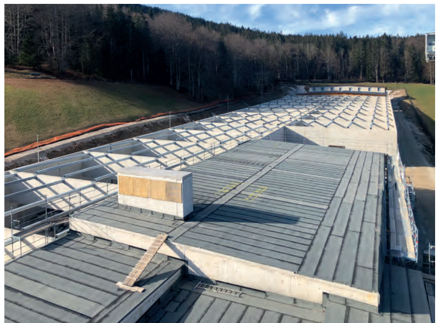
Blick auf die Anlage im Januar 2023
