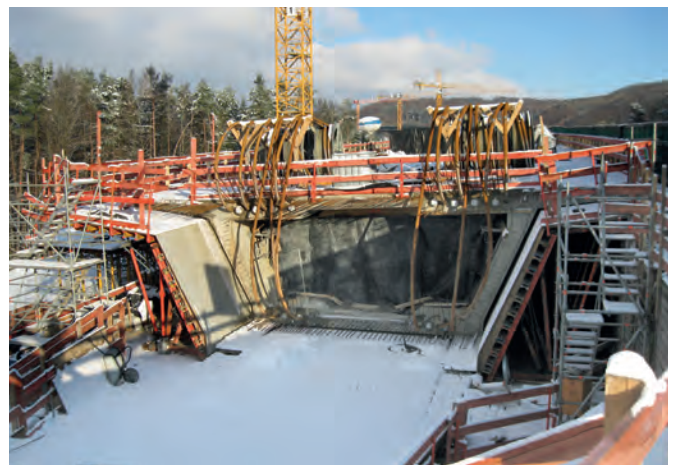
Talbrücke Unterrieden - Taktkeller
