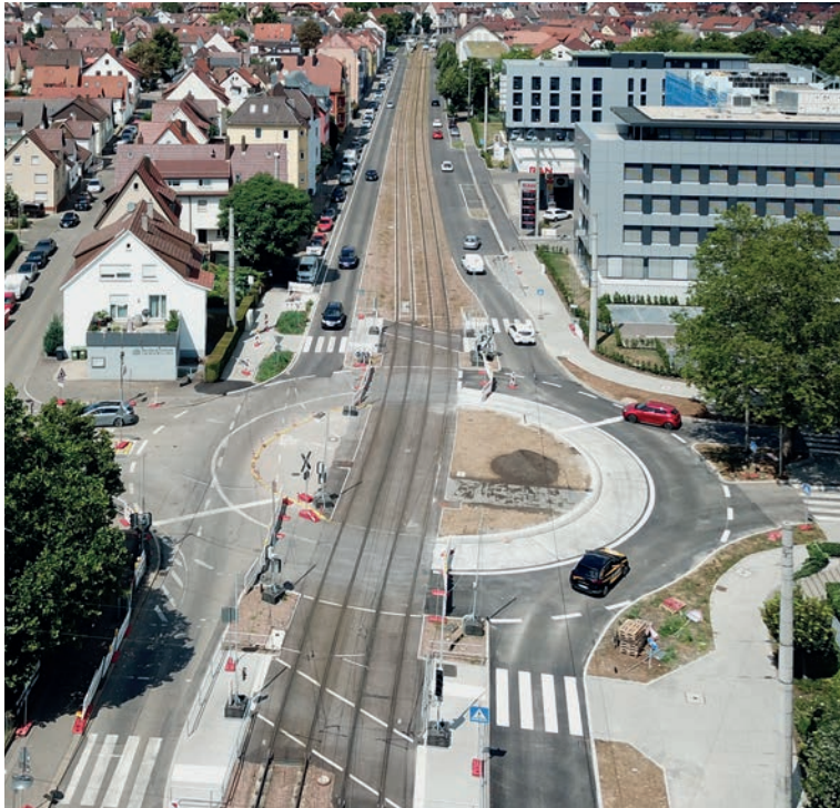
Baubabschnitt 1, Blickrichtung Norden; 1. Kreisverkehr im Umbau; rechte Ausfahrt Richtung Otto-Konz-Brücken
