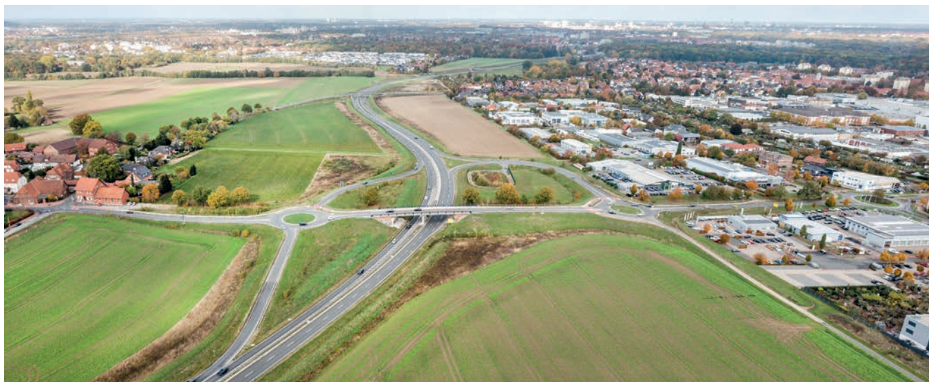
Knotenpunkt B3 / K 221, links Devese, rechts Gewerbegebiet Hemmingen, Blickrichtung Norden
