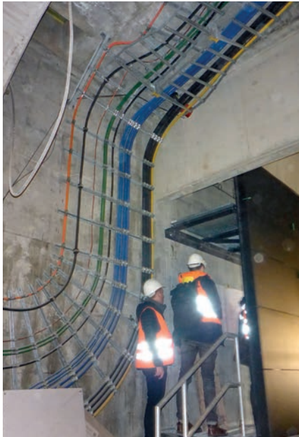
Unter den Linden, Hauptkabelquerung Foto: Winfried Kutz
