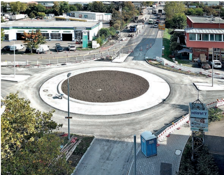
Baubabschnitt 1, Blick auf 2. Kreisverkehr Fahrrichtung Otto-Konz-Brücken
