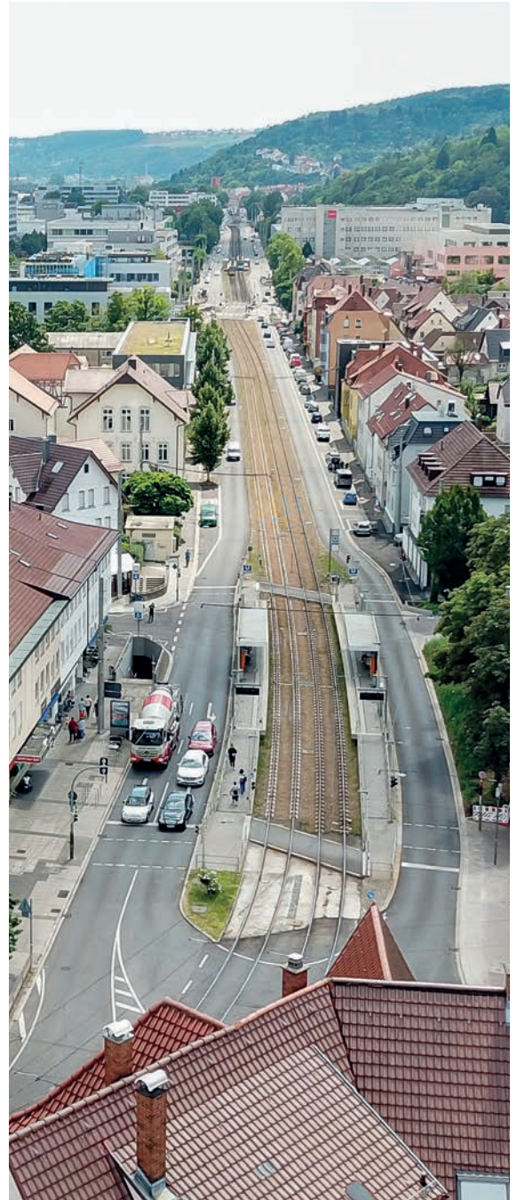
Baubabschnitt 1 im Vordergrund, Blickrichtung 2. Bauabschnitt (Süden)
