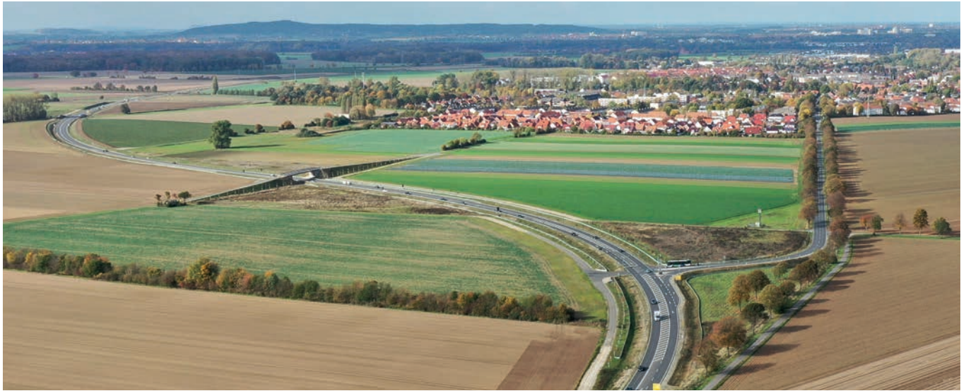
Bauende, neuer Knotenpunkt B 3 / Zufahrtstraße Hemmingen, Blickrichtung Norden
