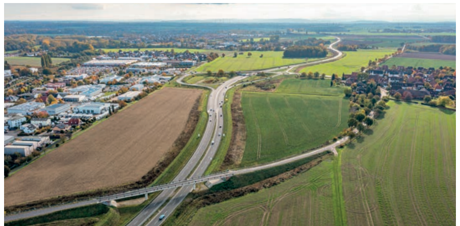
Brückenbauwerk Deveser Straße, Knotenpunkt B 3 / K 221, Blickrichtung Süden
