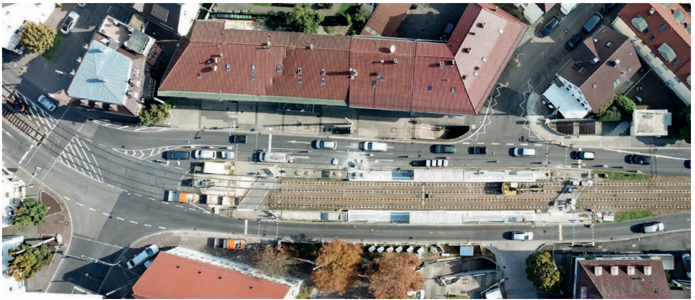
Baubabschnitt 1, Blick auf Haltepunkt Wangen Marktplatz im Bau
