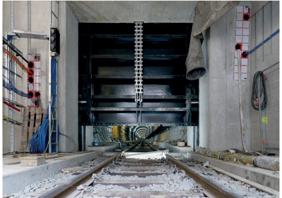
Gleiswechselanlage, Wehrkammertor Richtung Museumsinsel Foto: Antonio Reetz-Graudenz
