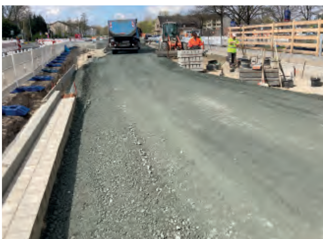
Heinrich-Plett-Allee - Herstellung des Gehwegs im Straßenkörper
