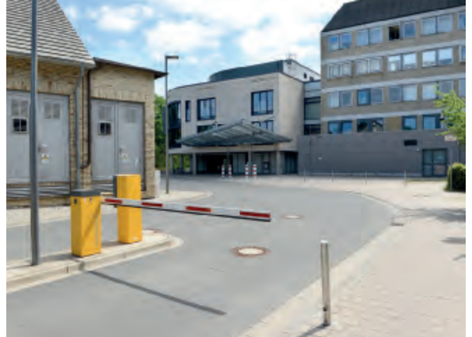
Blick auf die neue Somatik mit Vordach am Eingang
