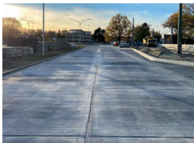
Bushaltestelle Roland-Center - nach dem Betoneinbau
