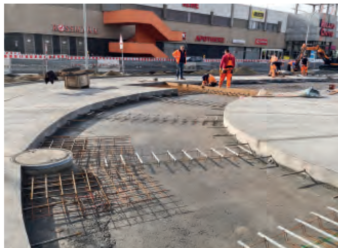
Bushaltestelle Roland-Center - vor dem Betoneinbau
