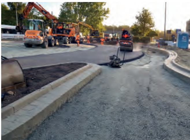
Bushaltestelle Roland-Center - Einbau Asphalttragschicht
